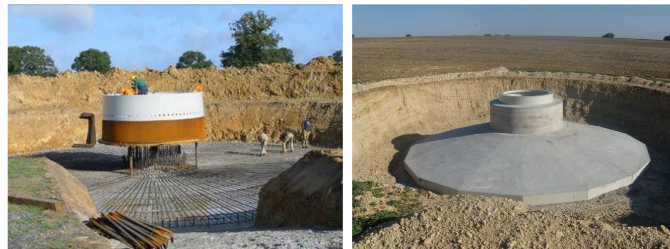
Photo 136 : Le coulage d'une fondation d'éolienne
