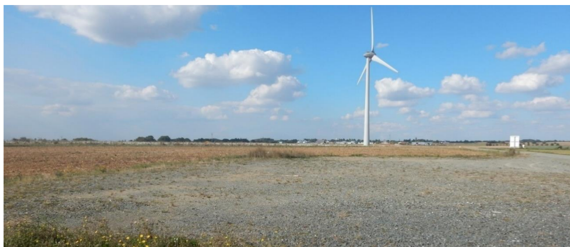
Photo 137 : un exemple d'aire de grutage depuis le pied d'une éolienne
